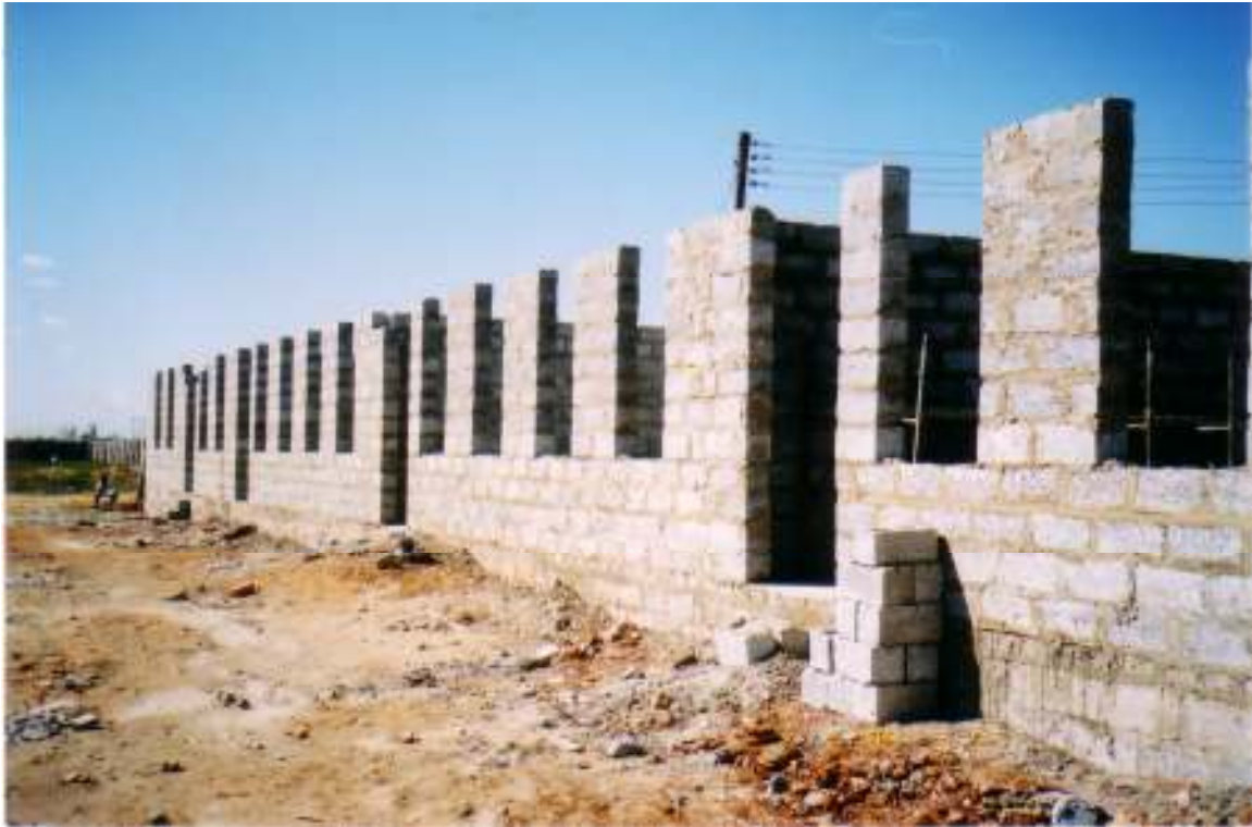
Ανέγερση Σχολείου Πρωτοβάθμιας Εκπαίδευσης στη Λουσάκα Χρηματοδότηση: HELLENIC AID Κατασκευή: ΜΚΟ «Euronet» Z A M B I A
