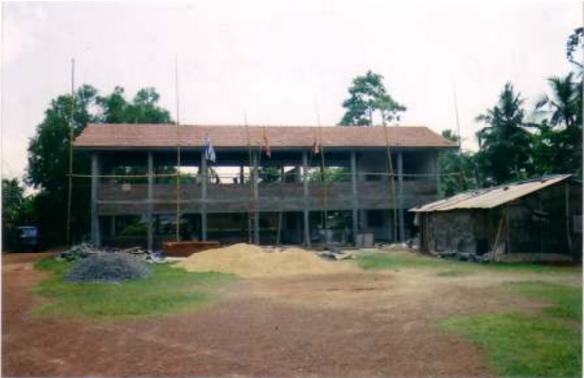
Κατασκευή Σχολείου στην περιοχή Galle Χρηματοδότηση: HELLENIC AID Κατασκευή: ΜΚΟ «Γιατροί Καρδιάς» Σ Ρ Ι Λ Α Ν Κ Α
