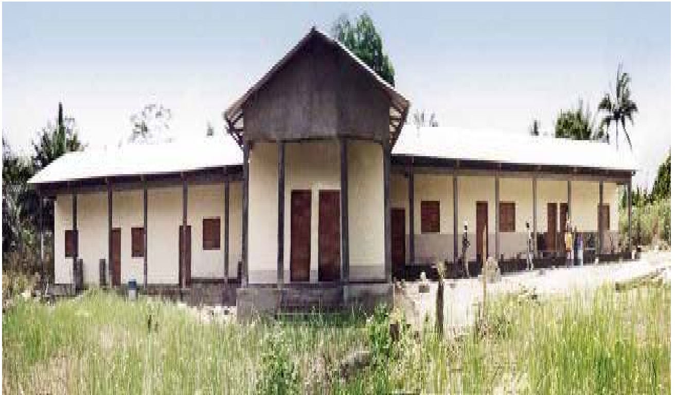
Κατασκευή κτιρίου Σχολείου στο χωριό Bonalea-Mantouka Χρηματοδότηση: HELLENIC AID Κατασκευή: ΜΚΟ «Φίλοι της Αφρικής» ΚΑΜΕΡΟΥΝ
