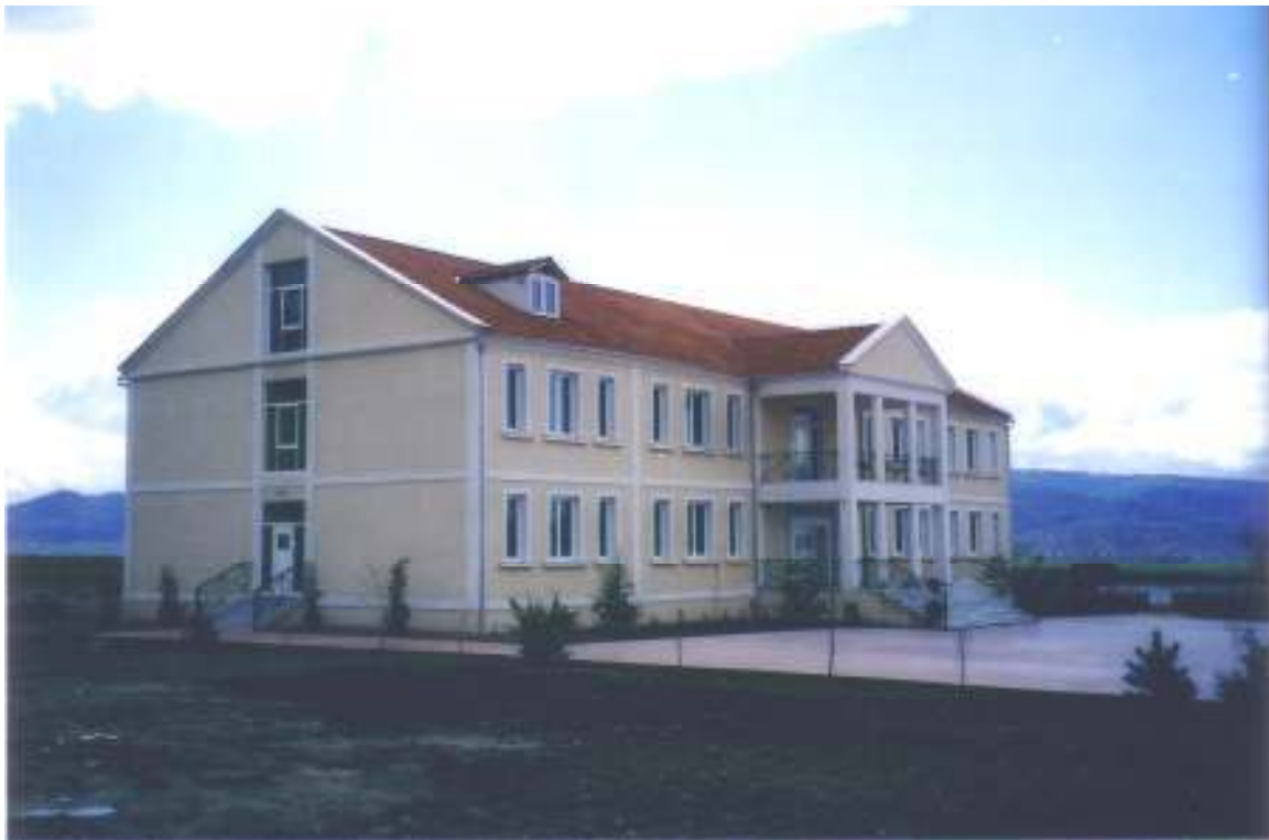
Κατασκευή Σχολείου Πρωτοβάθμιας Εκπαίδευσης «ΟΜΗΡΟΣ» στην περιοχή Κορυτσάς. Χρηματοδότηση: HELLENIC AID Κατασκευή: ΜΚΟ «Δίκτυο για τη Δημοκρατία στη Νότιο-Ανατολική Ευρώπη» ΑΛΒΑΝΙΑ
