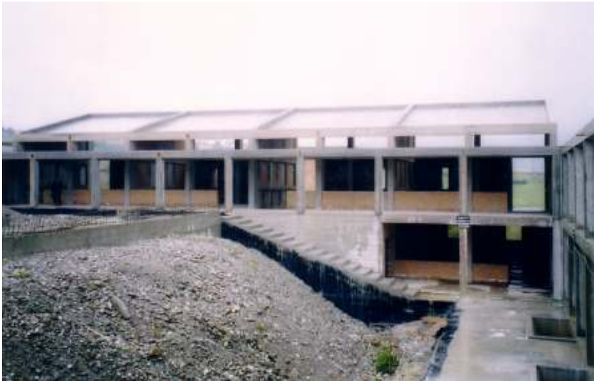
Κατασκευή Κτιρίων Σχολικού Συγκροτήματος «ΑΡΣΑΚΕΙΟΥ ΤΙΡΑΝΩΝ» Χρηματοδότηση: HELLENIC AID Κατασκευή: ΜΚΟ «Φιλεκπαιδευτική Εταιρεία» ΑΛΒΑΝΙΑ
